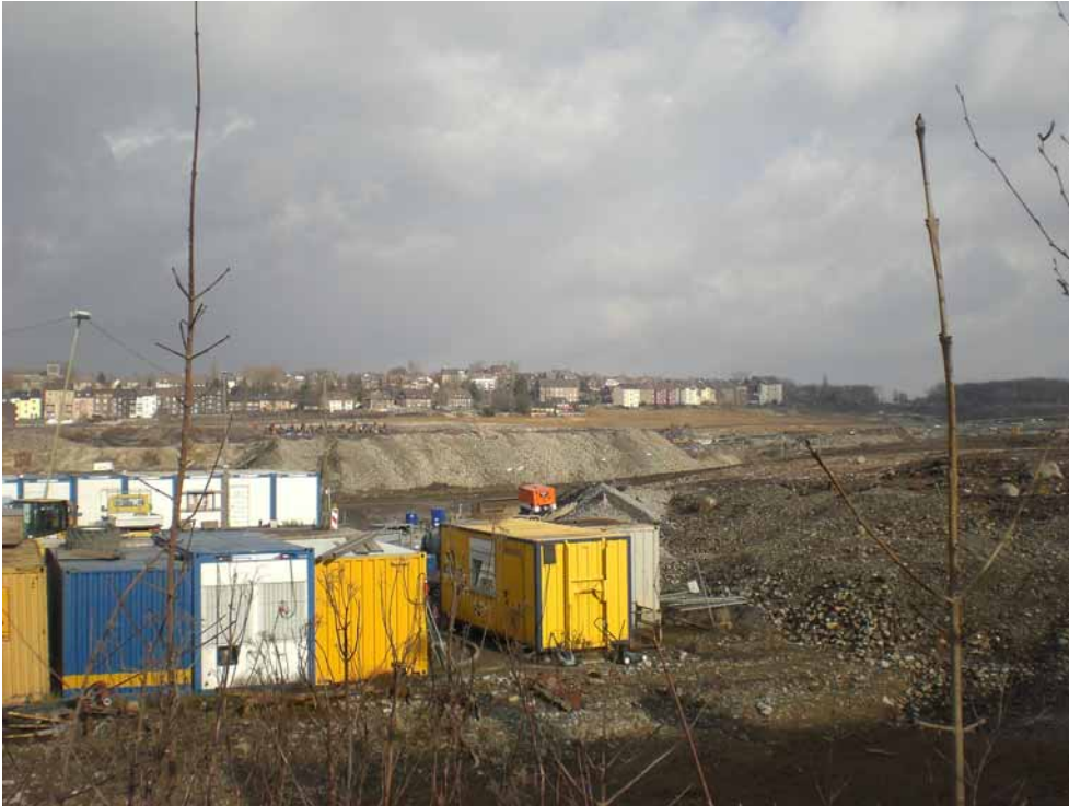
Abb. 4-20 Phoenix Ost in Dortmund, Rückbau eines Stahlwerks (Foto: Gabrian RVR)
