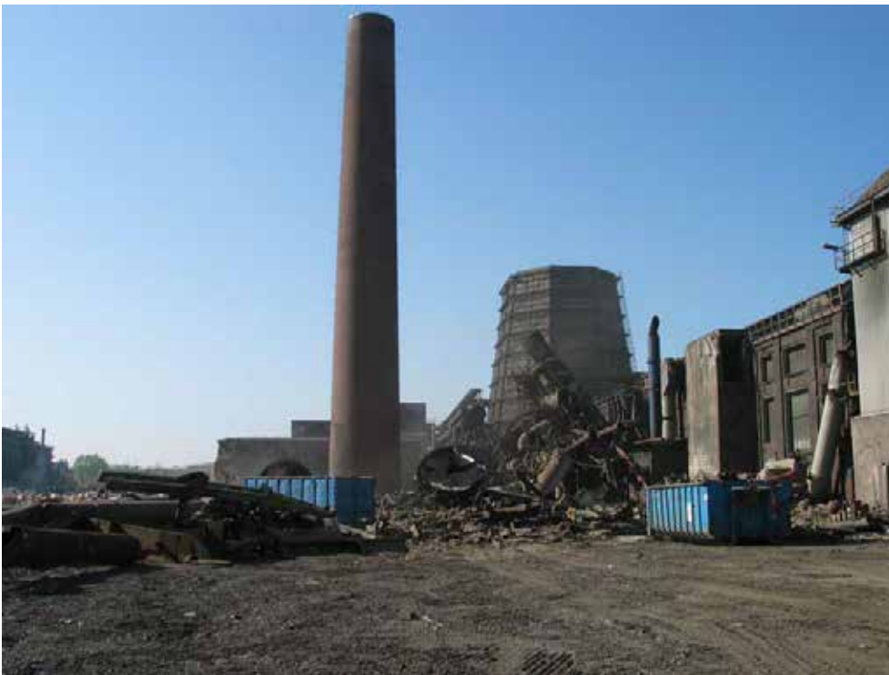
Abb. 4-21 Westfalenhütte Dortmund, Rückbau (Foto: Snowdon, RVR)
