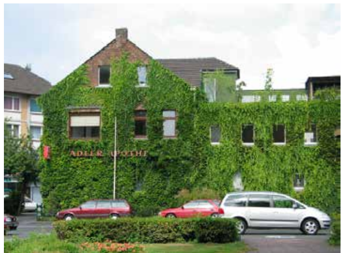
Abb. 4-18 Hauswandbegrünung (Foto: Snowdon, RVR)
